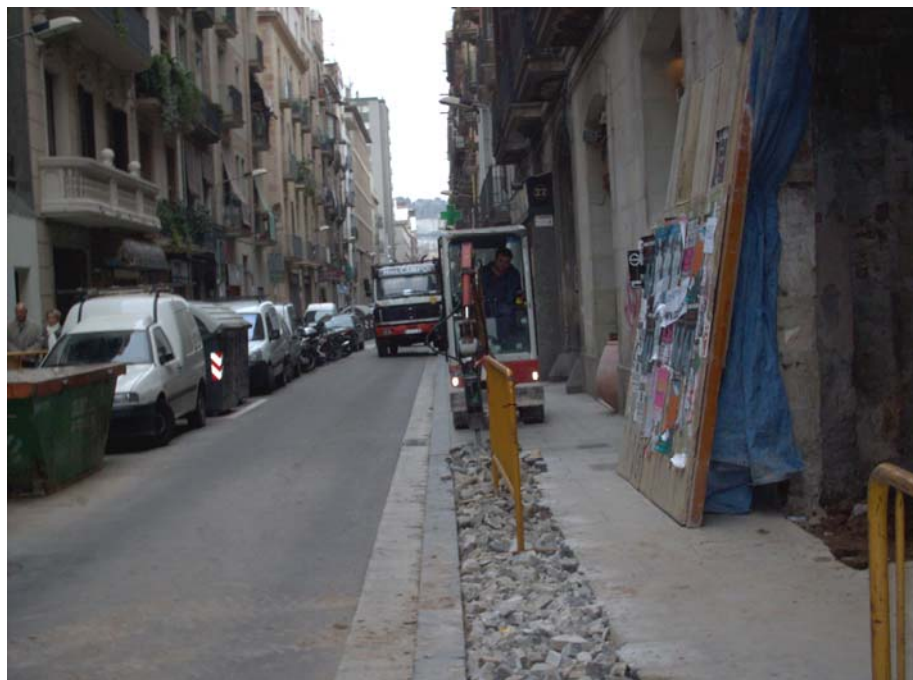
F 3. Rasa 2, Trencament de rajoles i formigó al carrer Nou de la Rambla.
