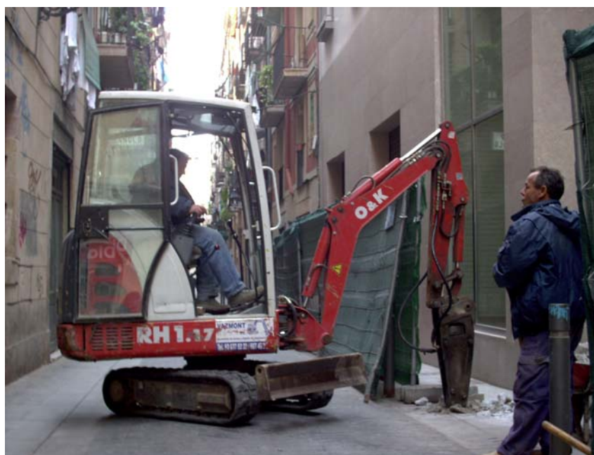
F 2. Rasa 1, Trencament de rajoles i formigó al carrer Lancaster.
