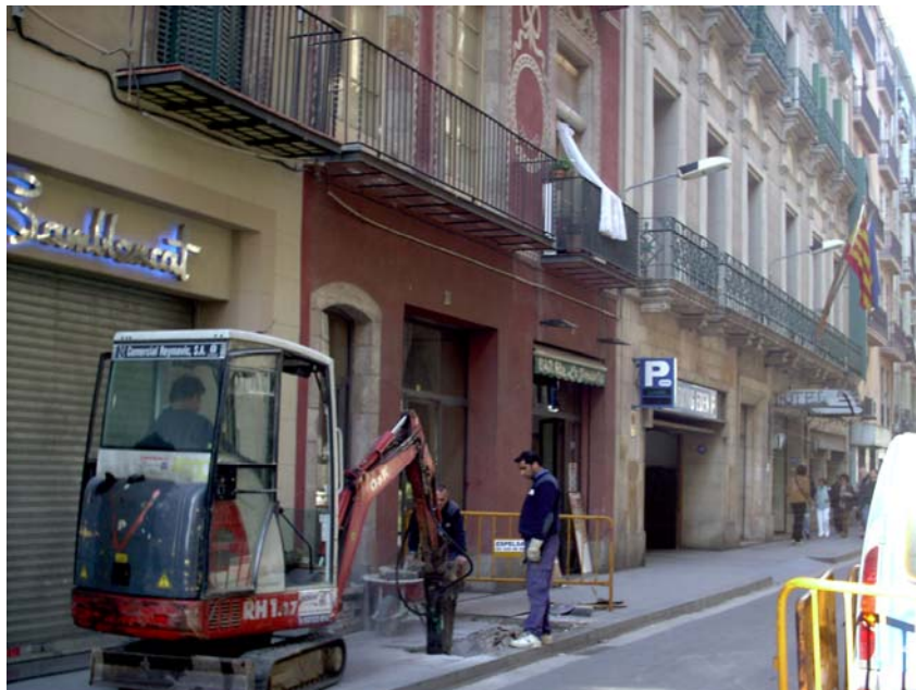
F 1. Rasa 1, Trencament de rajoles i formigó al carrer Nou de la Rambla.
