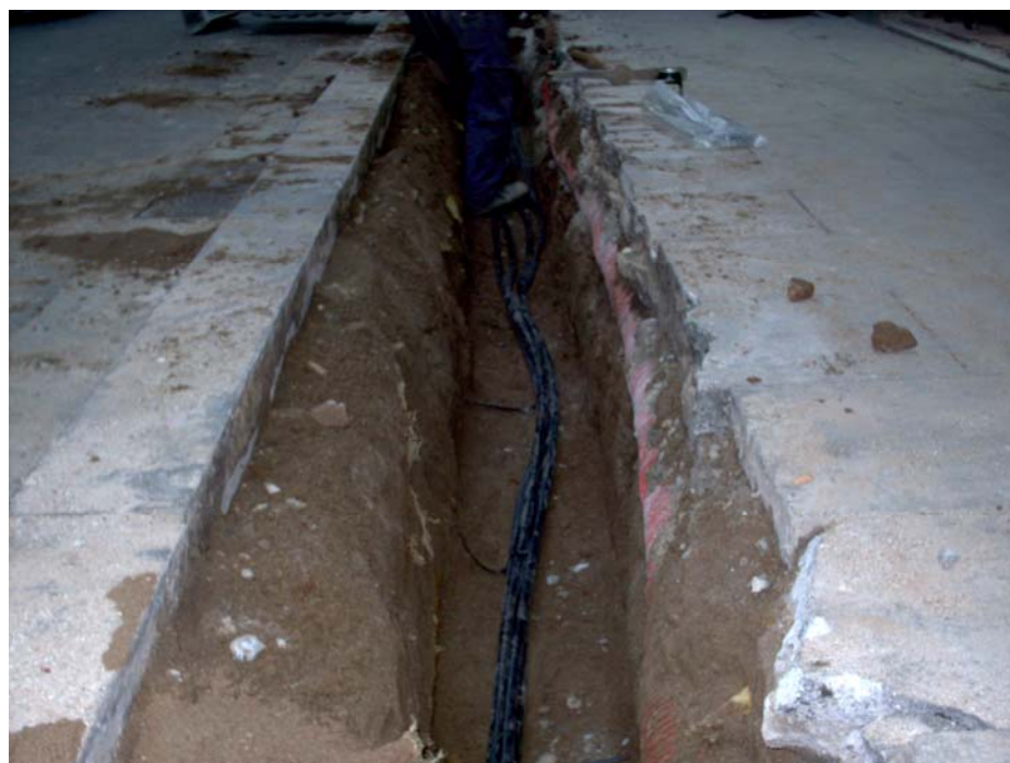
F 6. Rasa 2, Col.locació de cable.
